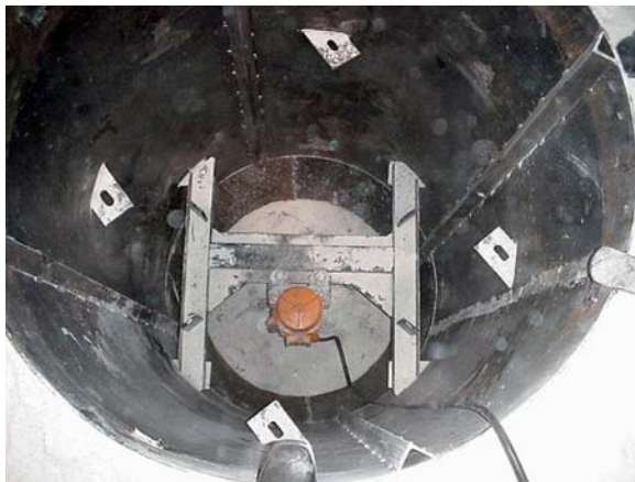
Рис. 2 «Пневматический вибратор Martin, установленный внутри шаблона»
