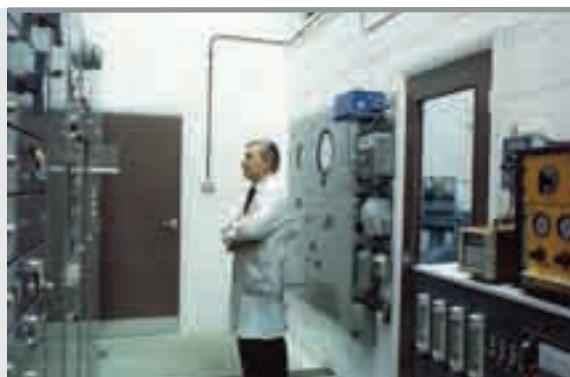
Помещение управления с блоками питания силовых и управляющих цепей пресса, печи и вспомогательных систем. В данной установке клапаны газовой системы имеют ручные приводы.
