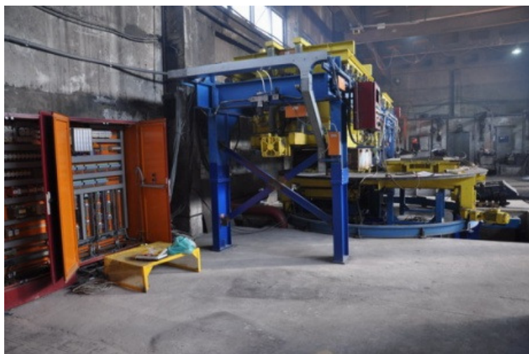
Рис.7. Монтаж карусельного формовочного автомата линии вакуумно-пленочных форм (ВПФ) фирмы HWS-Sinto, Германия на заводе Днепропромлит
