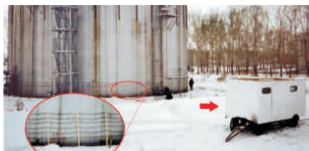
Общий вид всепогодной индукционной установки нагрева резервуара для нанесения защитного покрытия:
