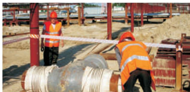
Выпускаемые компанией установки могут быть многофункциональными: так, например, установка ТП12-300 может одновременно осуществлять нагрев до 12 независимых зон с любым заданным алгоритмом нагрева и поддержания температуры. Допускается параллельная работа нескольких установок с соответствующим увеличением зон нагрева.
