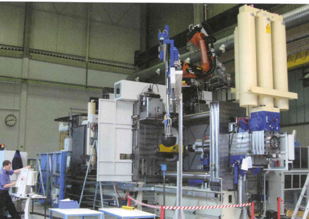
Рис. 3. Испытания всего участка перед отправкой.
