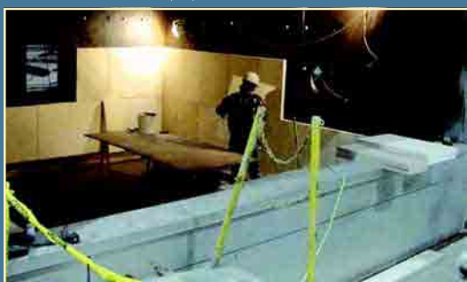
Установка изоляционной доски в дополнительной изоляции
