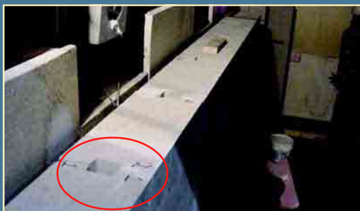
Стыки с кнопочным пазом
