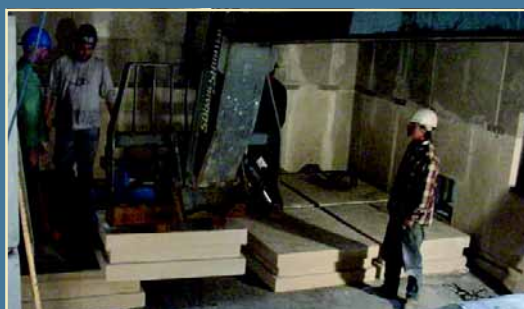
Установка литого блока в поду печи со встроенным контуром и скатом
