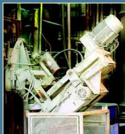
Установка HD-2000 на печи позиции для рафинирования с помощью вращающегося сопла.
